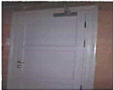
Bilde 2: Dører mellom loft og trapperom har brannmotstand B-60.
