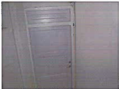
Bilde 1: Dører mellom boenhet og trapperommene oppgis å ha brannmotstand B-30.
