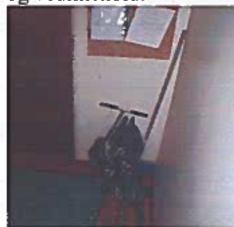
Bilde 9: Oppbevaring av gjenstander i trapperommet kan øke brannbelastningen og redusere fremkommeligheten ved en rømning/redningssituasjon.
