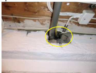
Kjeller: Hull tettes.
