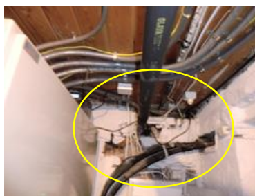
Kjeller: En mengde hull tettes.
