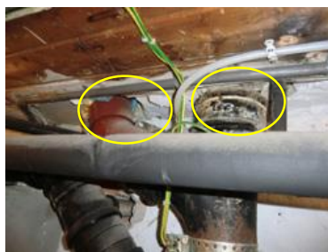
Kjeller: Hull rundt rør tettes.
