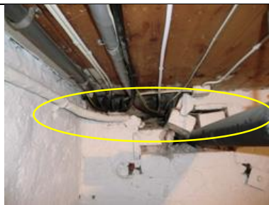
Kjeller: Store hull må tettes.
