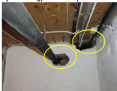
Kjeller: Hull må tettes.
