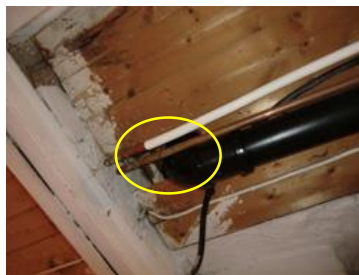
Kjeller: Hull rundt rør tettes. Plastrør påmonteres brannmansjett.
