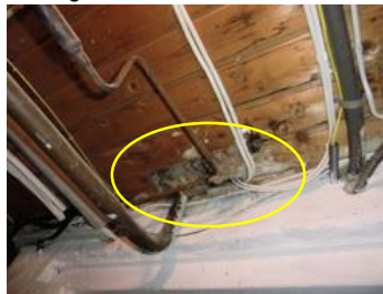
Kjeller: hull tettes.
