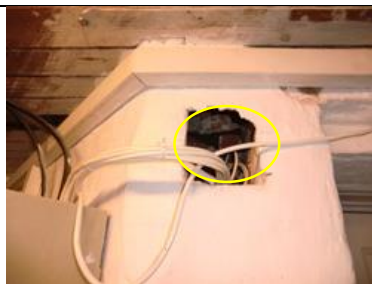
Kjeller: Hull tettes.
