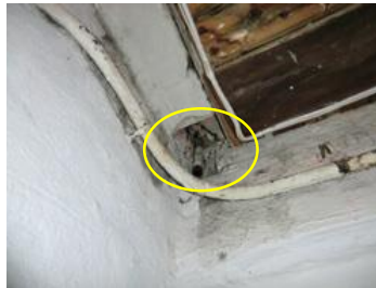
Kjeller: rør fjernes og hull tettes.
