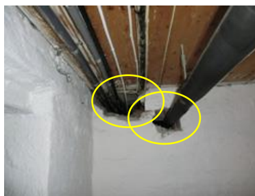
Kjeller: Hull tettes.
