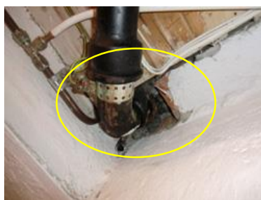
Kjeller: Hull rundt rør tettes.
