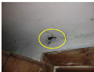
Kjeller: Hull tettes.
