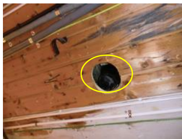
Kjeller: Hull tettes.
