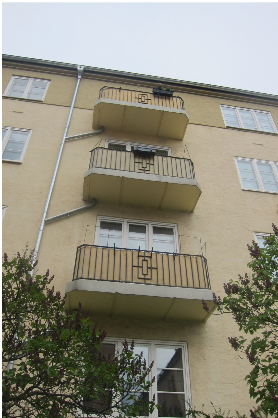
Balkonger i Hammestads gate 19 ( Tilnærmet tilbuds rekkverk)
